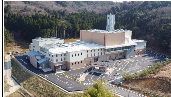
写真① 施設正面(航空写真)
