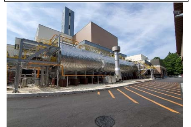
⑥メタン発酵槽
