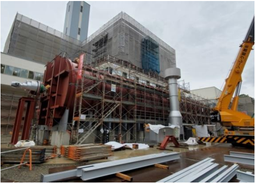
写真① メタン発酵槽
