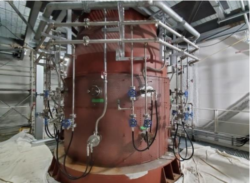
写真③ 配管・サポート 敷設
