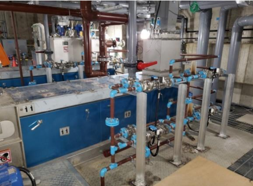
写真④ 配管・サポート 敷設
