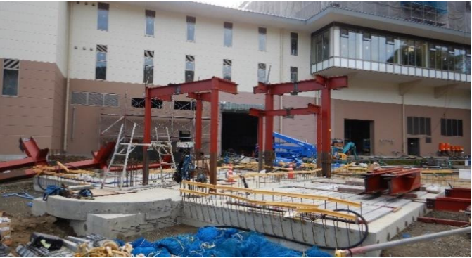
写真⑤ 計量棟 鉄骨建て方施工状況
