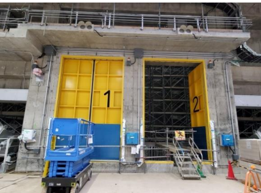
写真⑥ 配管・電線管 敷設
