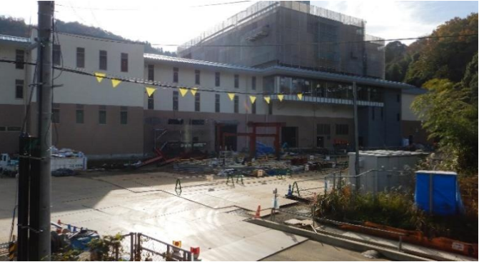
写真⑦ 進入路(現場側)ヤード全景
