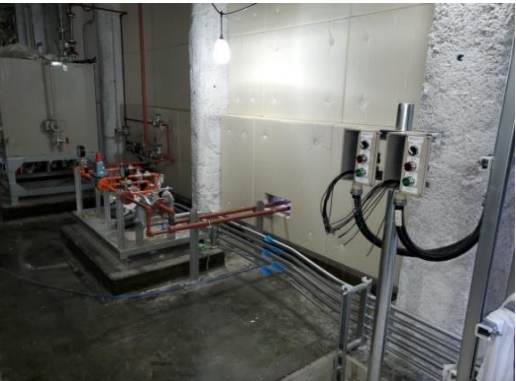
写真⑤ 配管・電線管 敷設
