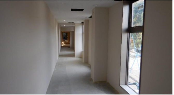
写真⑥ 2階廊下 内装仕上げ施工状況
