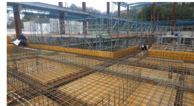
写真⑤ ごみピットエリア・炉室エリア 3階躯体・4階スラブ
