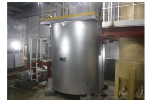
写真⑥ 凝集沈殿槽
