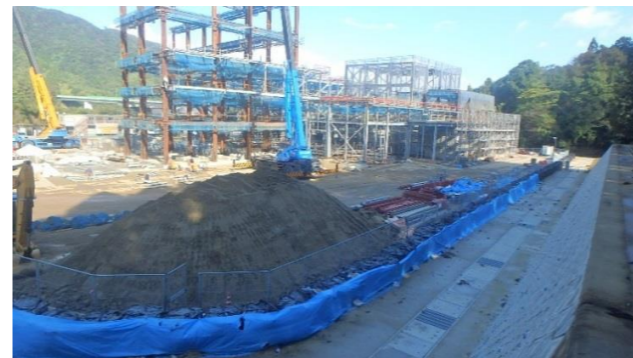
写真① 敷地東側全景(南角から)
