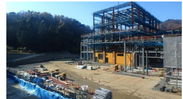
写真② 炉室・ごみピット・プラットフォームエリア(南東から)
