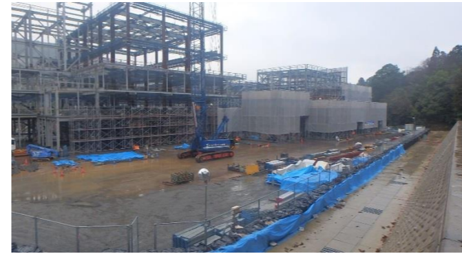
写真① 敷地東側全景(南角から)
