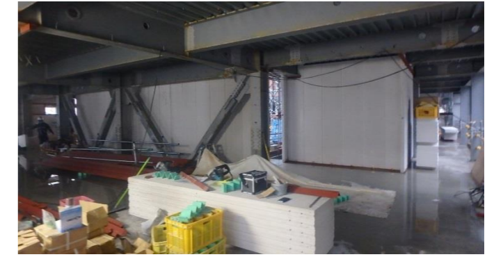
写真⑥ リサイクルエリア 内外壁ALC下地・建込
