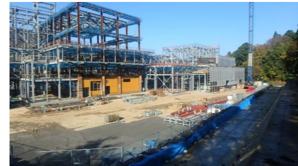
写真① 敷地東側全景(南角から)
