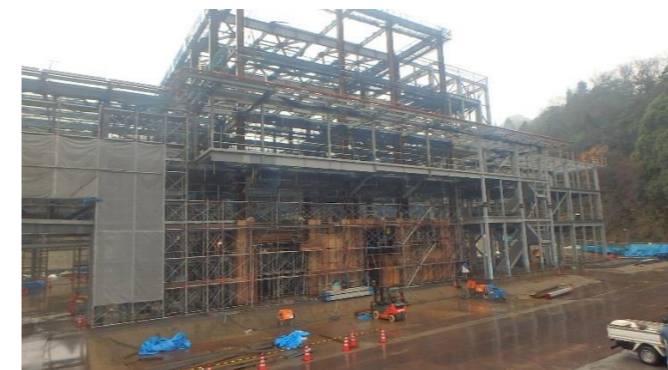
写真⑤ ごみピットエリア・炉室エリア
