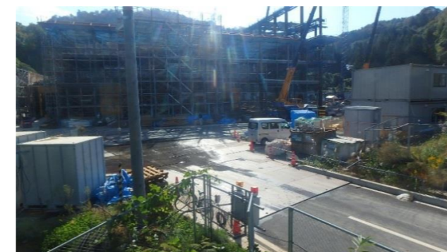
写真⑦ 進入路(現場側)ヤード全景
