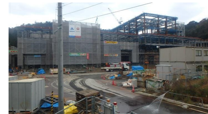
写真⑦ 進入路(現場側)ヤード全景
