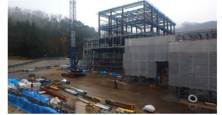
写真② 炉室・ごみピットプラットフォーム(南東から)
