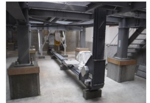
写真④ 飛灰搬送コンベヤ
