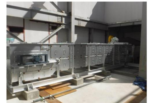
写真⑧ 飛灰処理物搬送コンベヤ
