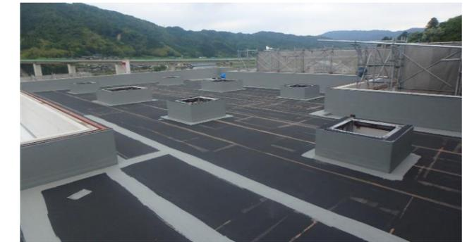
写真⑥ リサイクルエリア 屋根シート防水
