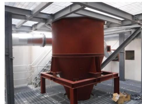
写真⑤ 飛灰貯留槽
