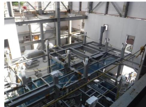
写真③ 焼却炉架台
