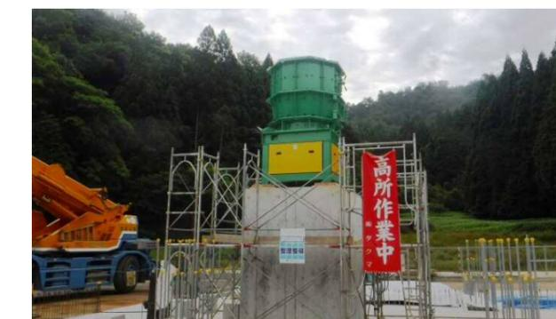
写真⑧ 高速回転式破碎機 据付完了
