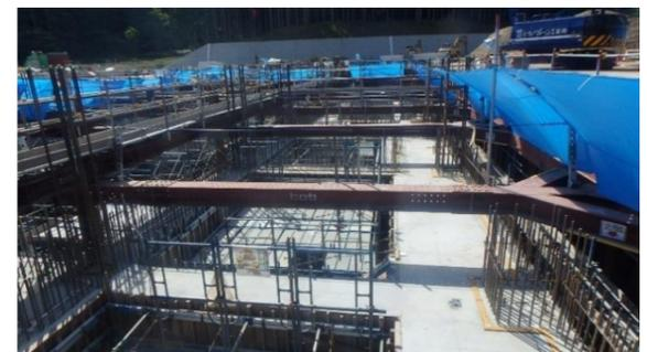
写真④ ごみピットB2階躯体・B1階スラブ CON打設完了
