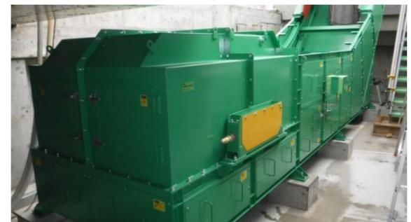
写真⑧ 不燃・粗大ごみ供給コンベヤ据付完了
