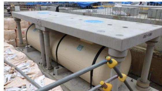
写真⑤ 助燃油貯留槽 据付完了
