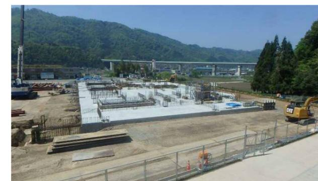
写真⑧ リサイクル棟 土間スラブコンクリート打設完了
