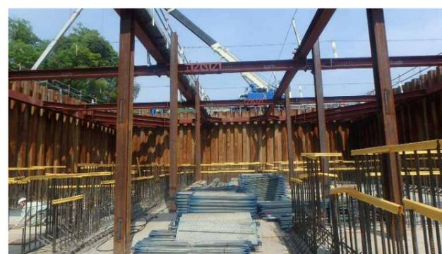
写真⑦ ごみピット B2階地中梁外周埋戻し完了
