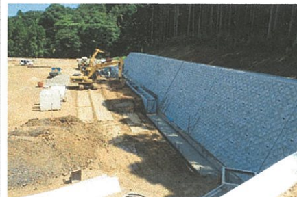
写真⑤ 造成部東側
