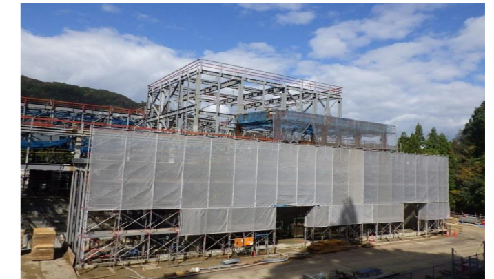
北東側全景(2018年10月)
